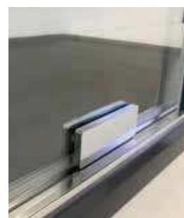
Rodamiento integrado en hoja
