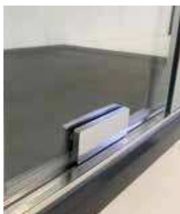
Rodamiento integrado en hoja
