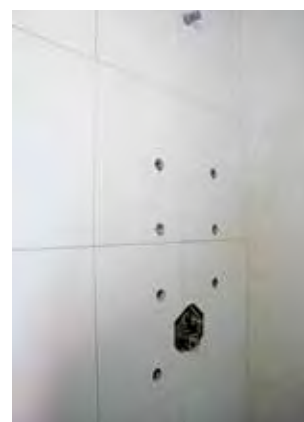
#4 Instalación de complementos.
