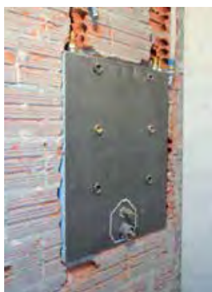
#2 Fijación a pared y conexión de tomas.
